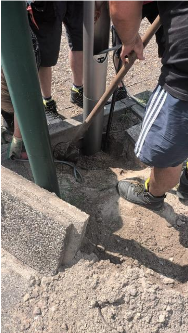
Elektriciteitskabel wordt aangesloten
