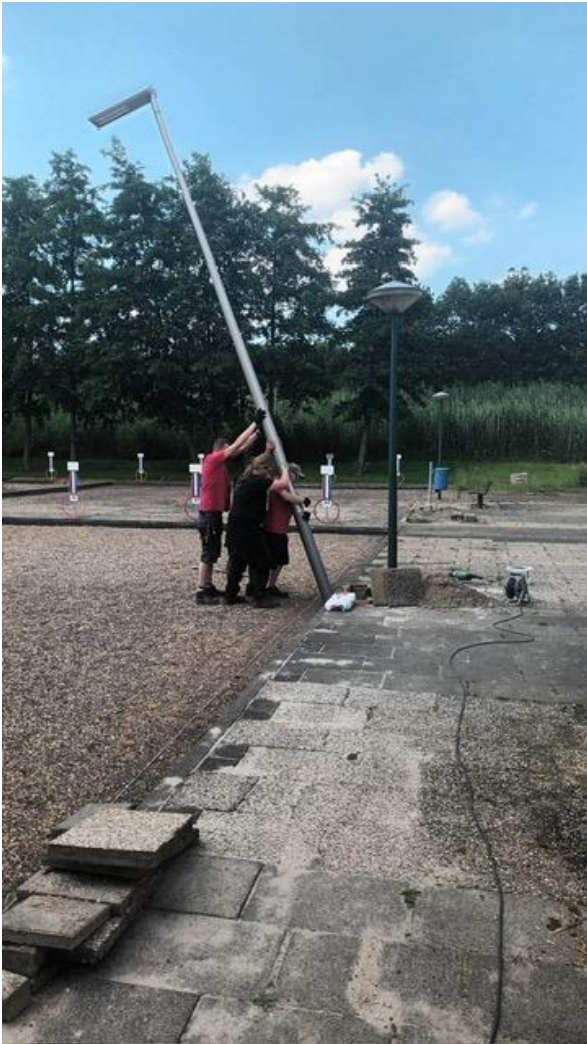
De nieuwe lichtmast wordt geplaatst
