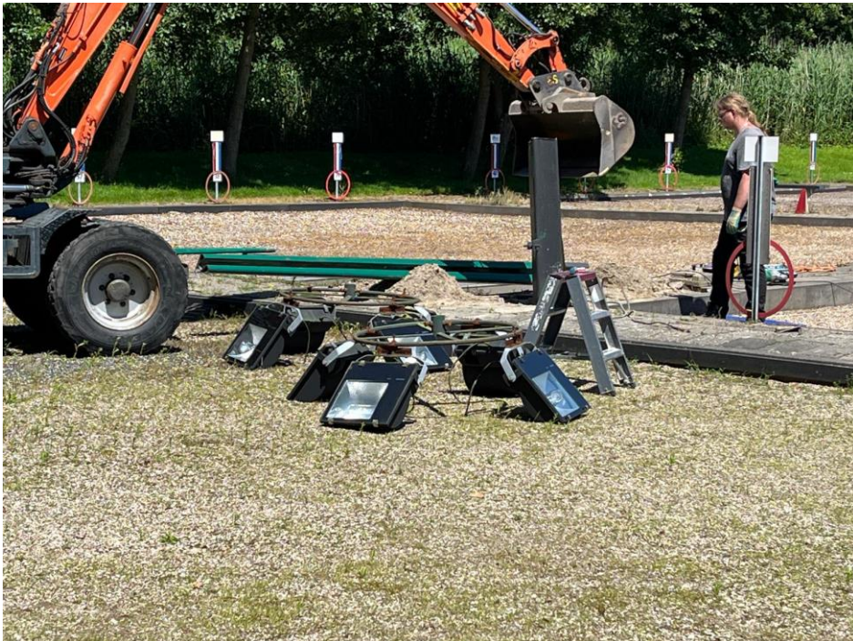
Het onderste deel van de lichtmast wordt uit de grond getrokken.
