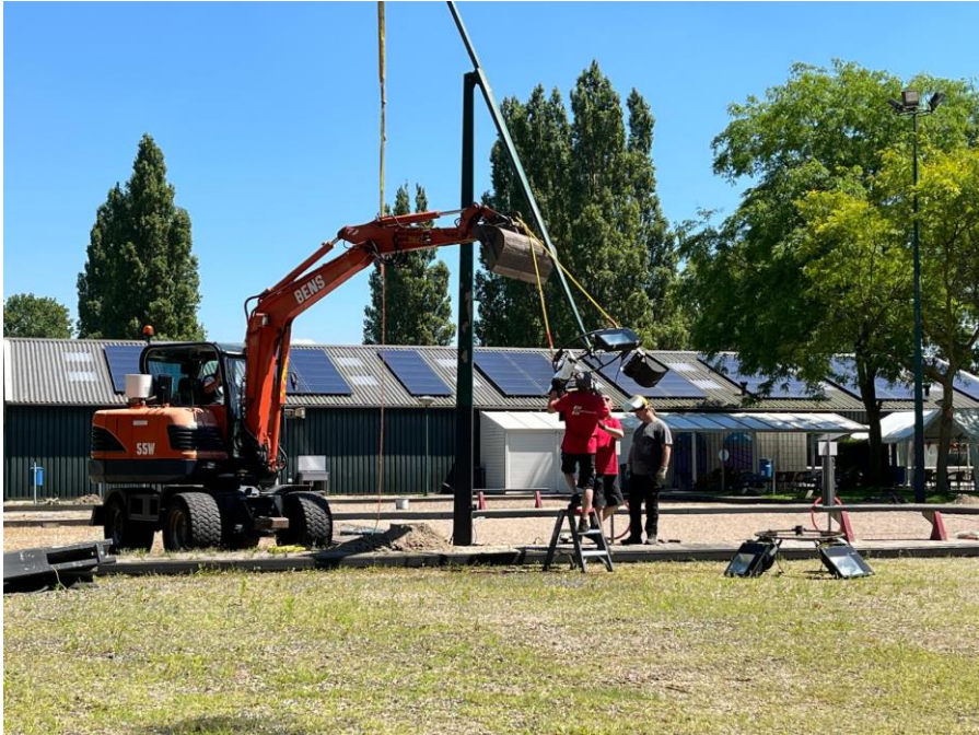
Het neerhalen van het bovenste deel van de lichtmast
